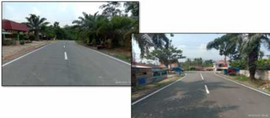
PENINGKATAN JALAN ABAI SANGIR - SEI. DAREH (P.056.3) KAB. DHARMASRAYA
