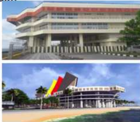
Pembangunan Gedung Kebudayaan
