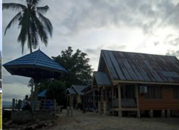
6. INSTALASI KKD PASAMAN BARAT
