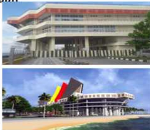
Pembangunan Gedung Kebudayaan
