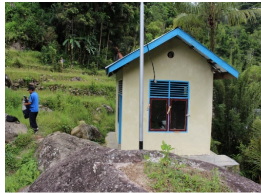
PLTMH Kab. Pesisir Selatan
