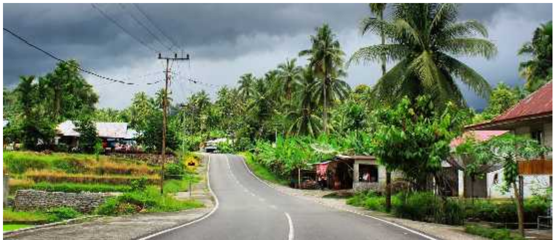
Gambar 3. 1 Pembangunan Jalan Provinsi
