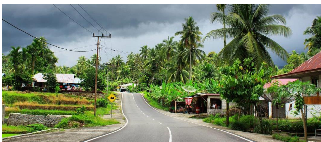
Gambar 3. 9 Pembangunan Jalan Provinsi
