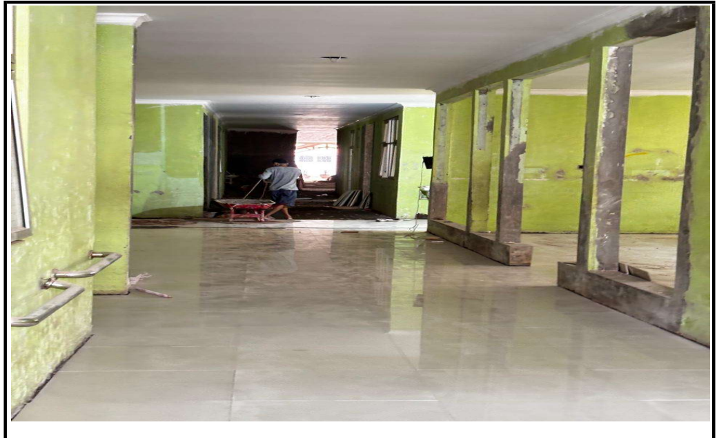
GEDUNG BEDAH Sedang Dikerjakan 50%
