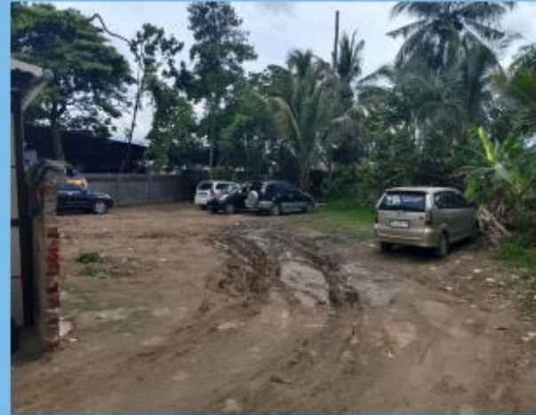
Penambahan dan proses perbaikan lahan parkir RSUD M. Natsir
