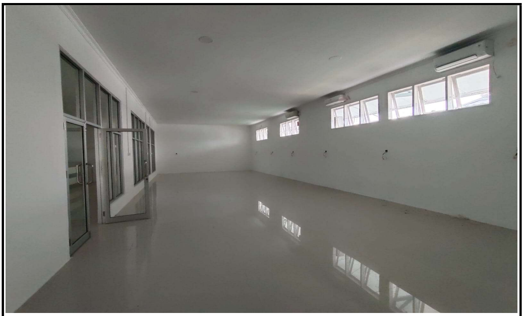
GEDUNG NEUROLOGI Sesudah Dikerjakan 100%
