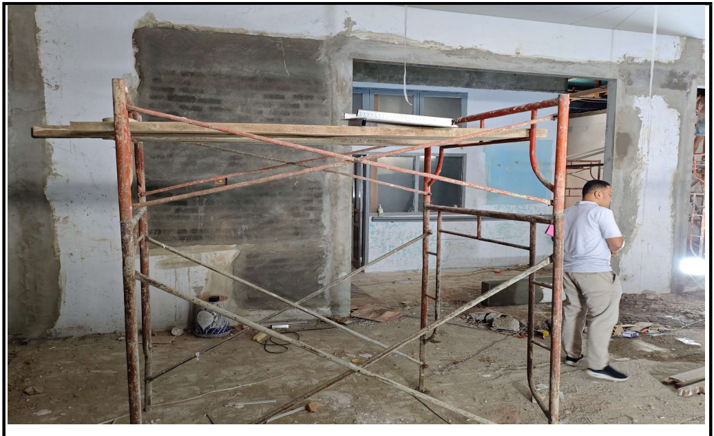
GEDUNG NEUROLOGI Sedang Dikerjakan 50%
