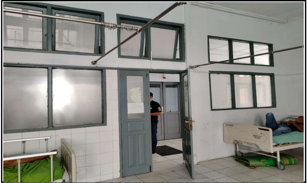
GEDUNG NEUROLOGI Sebelum Dikerjakan 0%
